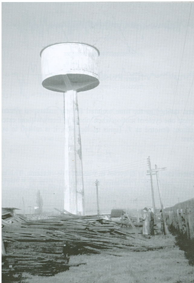
شکل (۲-۱): این مخزن بتن مسلح که بر روی یک ستون منفرد ۴۰ فوتی قرار دارد و در نزدیکی فرودگاه والدیویا واقع شده است در زلزله ماه مه ۱۹۶۰ شیلی آسیب ندید. در زمانیکه مخزن پر از آب باشد سازه را می توان به صورت یک سیستم تک جرمی متمرکز در نظر گرفت. (از مجموعه ک. وی. اشتنبرگ، با تشکر از مرکز اطلاعات ملی مهندسی زلزله دانشگاه برکلی کالیفرنیا)
