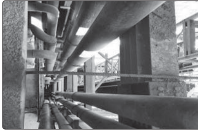
شکل ۲-۸- سینک فلزی ظرفشویی و رایزر تأسیسات مکانیکی (حاوی لوله‌های آب، گاز، تهویه مطبوع و...) نمونه‌هایی از هادی‌های بیگانه هستند.
