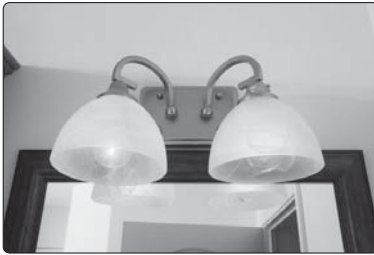
شکل ۲-۴- موتور الکتریکی و چراغ دیواری تجهیزات نصب ثابت هستند.
