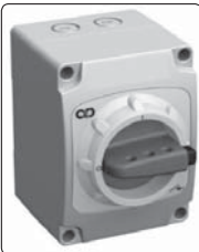
شکل ۲-۱۹- یک نمونه کلید جداکننده زیر بار
