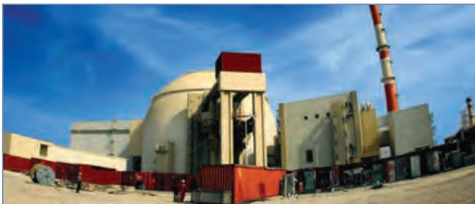
نیروگاه اتمی بوشهر
