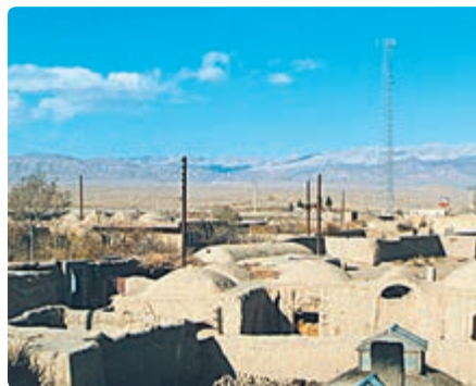
شکل ۴۱-۲- سقف خانه‌ها در مناطق گرم - سمنان
