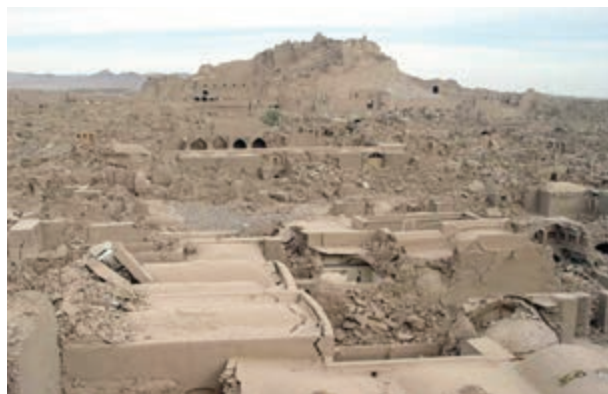
ب- ارگ بم بعد از وقوع زلزله
