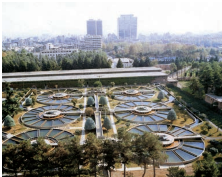
شکل ۱۲-۹- تصفیه خانه شماره ۲ آب تهران - جلالیه
