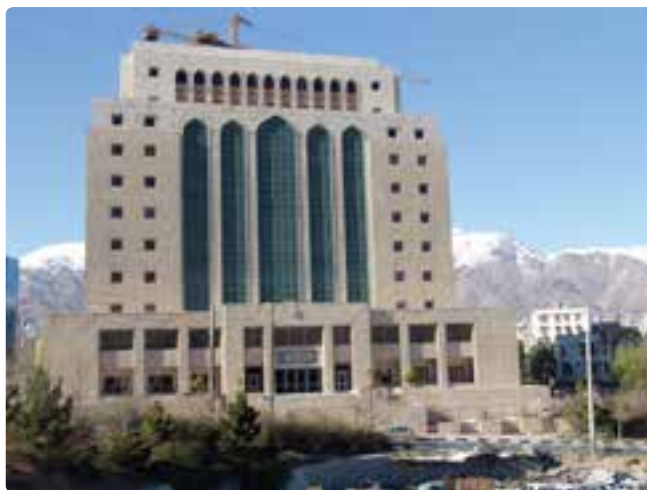
ساختمان گنجینه اسناد ملی
