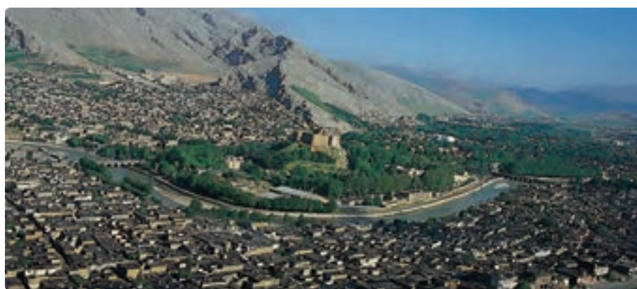
شکل ۲۵-۷- قلعه فلک الافلاک - خرم آباد
