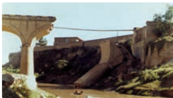
شکل ۱۵-۶- تخریب یک پل ارتباطی بر اثر سیل
