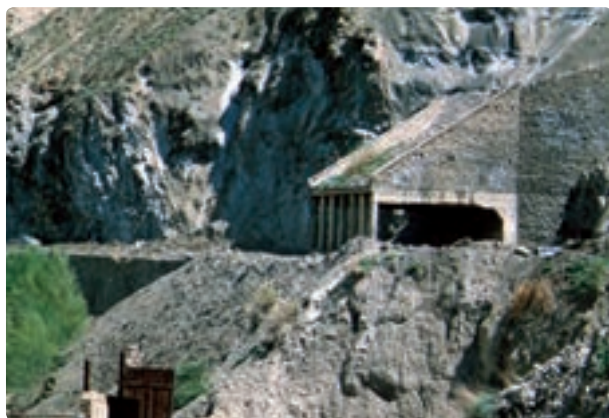
شکل ۲۵-۶- بهمن گیر راهی برای مقابله با خطر بهمن - جاده هراز
