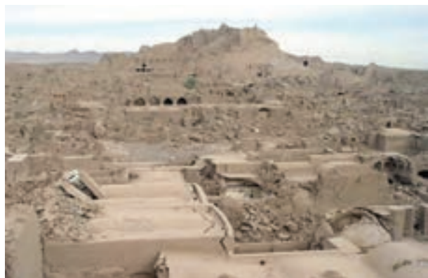
ب- ارگ بم بعد از وقوع زلزله
