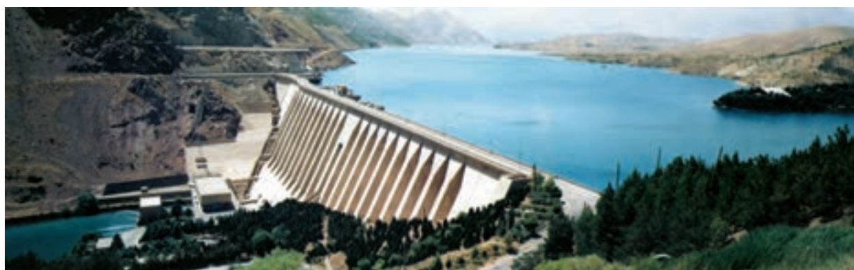
شکل ۲۶-۶- احداث سد روشی برای کاهش خطر خشک‌سالی
