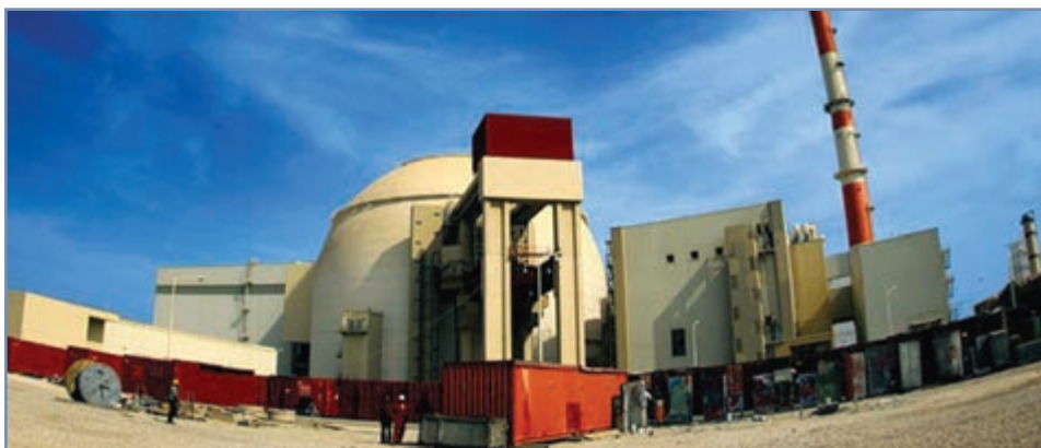
نیروگاه اتمی بوشهر
