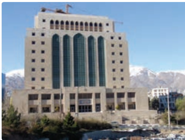
ساختمان گنجینه اسناد ملی
