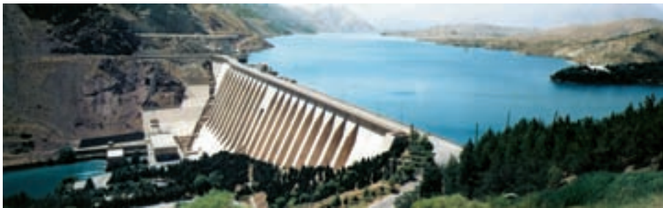
شکل ۲۶-۶- احداث سد روشی برای کاهش خطر خشک‌سالی
