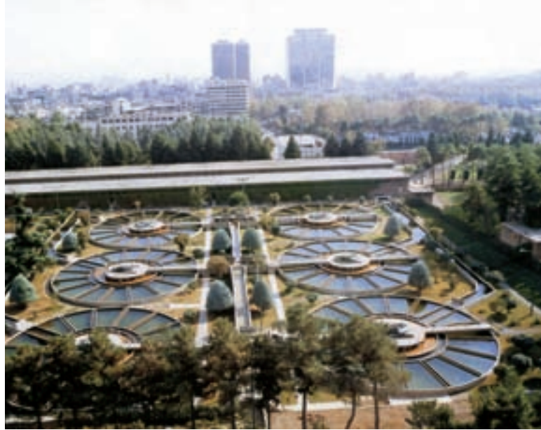
شکل ۱۲-۹- تصفیه‌خانه‌ی شماره ۲ آب تهران - جلالیه
