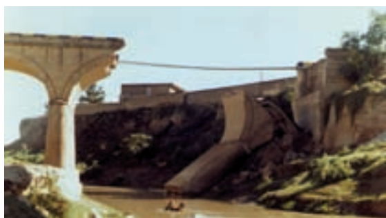
شکل ۱۵-۶- تخریب یک پل ارتباطی بر اثر سیل
