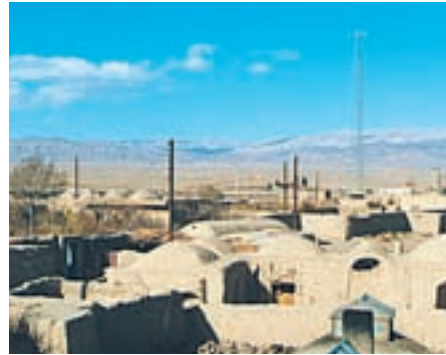
شکل ۴۱-۲. سقف خانه‌ها در مناطق گرم - سمنان
