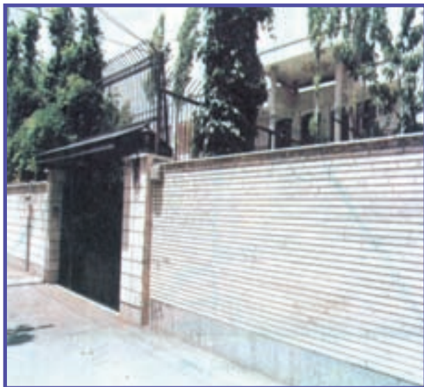
شکل ۴- دیوار خانه‌ها در شهر تهران
