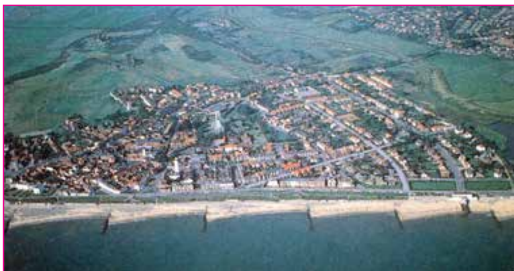
شکل ۷- احداث حفاظ در سواحل ماسه‌ای
