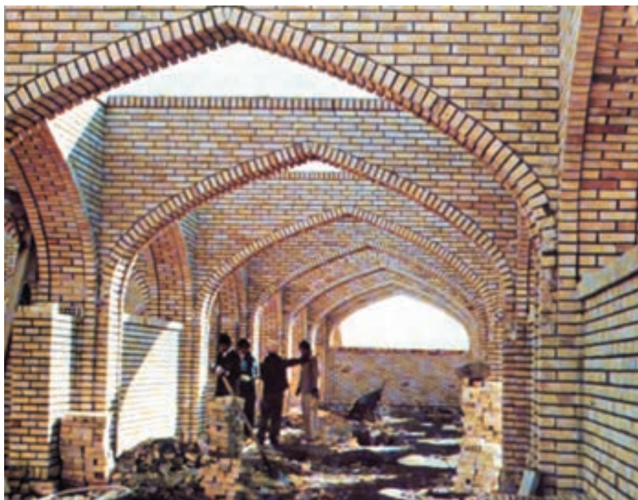
نمای داخلی کتابخانه تازه تأسیس هویزه
