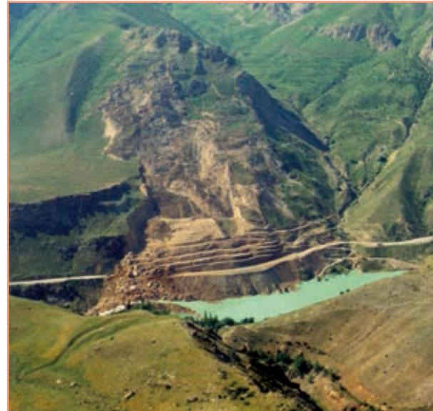
شکل ۶-۲۳ - تشکیل دریاچه به وسیله سد طبیعی از لغزش دامنه‌ها در منطقه آب‌اسک جاده هراز
