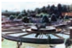
نمای بخشی از تصفیه‌خانه‌ی شهر تهران
