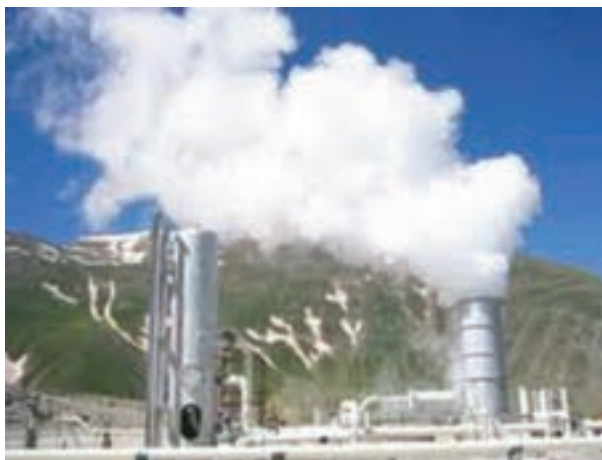
شکل ۱-۸- نیروگاه زمین گرمایی مشکین‌شهر - اردبیل
