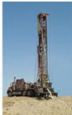
دکل حفاری چاه آب
