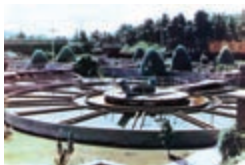
نمای بخشی از تصفیه‌خانه‌ی شهر تهران
