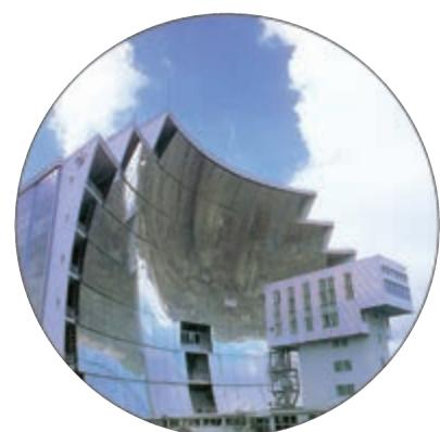
شکل ۱۶-۱— نمایی از نوعی کوره خورشیدی که در آن از آینه‌های مقعر بزرگ استفاده شده است.
