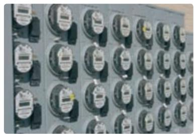
شکل ۲۴-۳ - کنتور برق برای اندازه‌گیری انرژی الکتریکی مصرفی بدکار می‌رود.
